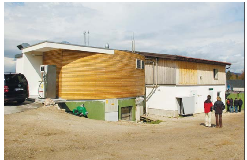
Einer der beiden Fermenter der Graskraftanlage in Reitbach wurde nachträglich mit dem Technikgebäude für die Gasaufbereitung überbaut.
