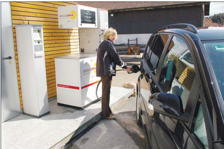
Getankt wird in Reitbach zwar direkt auf dem Fermenter, aber aus dem Zapfschlauch kommt Mischgas aus der Erdgasleitung.
